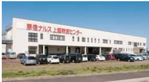
上越チルドセンター [2008年7月稼働]
