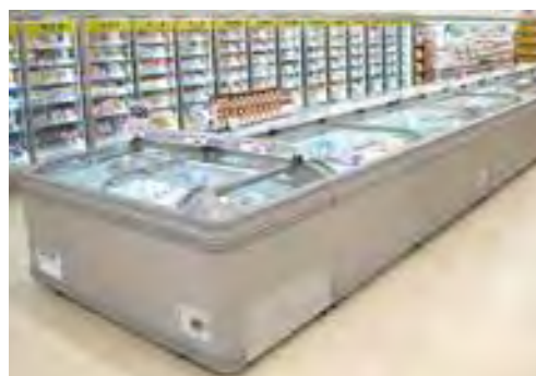
R290使用の冷凍ショーケース
